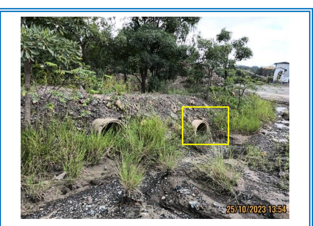
รูปที่ 3-19 ท่อระบายน้ำลงสู่บ่อตกตะกอน
